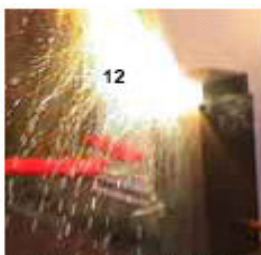
12. Dispare o acendedor de uma posição lateral à abertura do molde. A chama pode ser projetada para frente.
